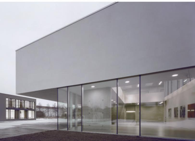
Putzfassaden sind typisch für das Bauen in der Oberlausitz. Diese Tradition führten die Architekten fort, allerdings mit einem modernen Element: In den Oberputz wurde Glimmer eingearbeitet.
