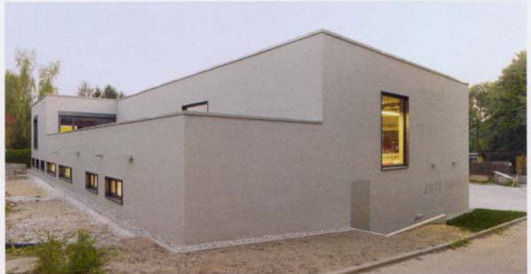
Baukörper mit eingeschnittener Dachterrasse © Christoph Kraneburg
