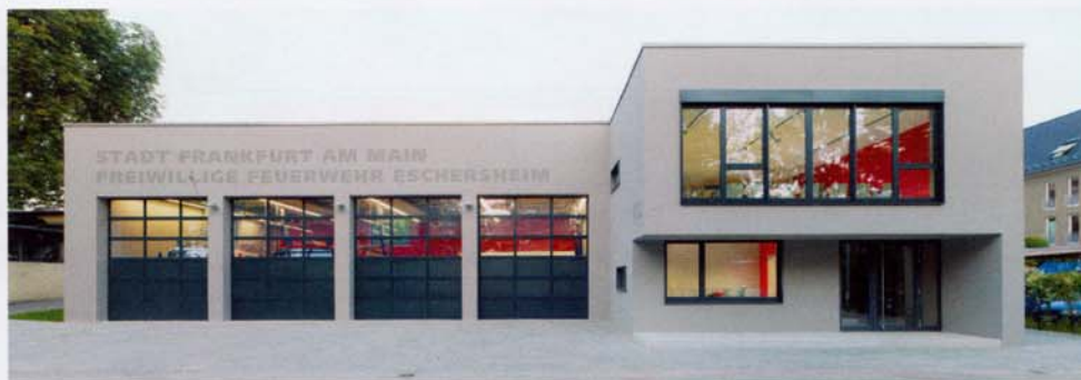
Eingangsfassade: Rolltore und Hoffenster © Christoph Kraneburg
